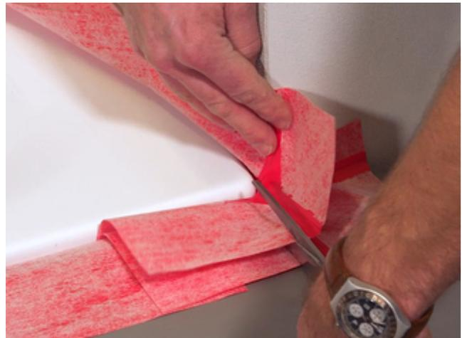
8) Die beiden übereinander geklebten Multiecken werden eingeschnitten, um diese miteinander eindichten zu können: Die oben liegende Multiecke auf der linken Seite einschneiden, die unten liegende auf der rechten Seite.
