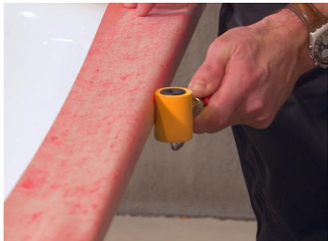
4) Nach dem Abziehen der Schutzfolie vom Klebestreifen das Sopro WannenDichtBand gerade an den Wannenrand ankleben. Mit Hilfe eines Rollers kann das Band im Anschluss fest angedrückt werden.
