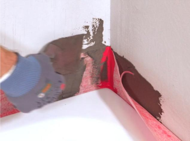
9) Bänder und Formteile in eine Schicht aus im System geprüften Stoß- und Überlappungskleber vollflächig einlegen. Mit Kelle oder Farbrollen- Bügel alle Teile fest andrücken.
