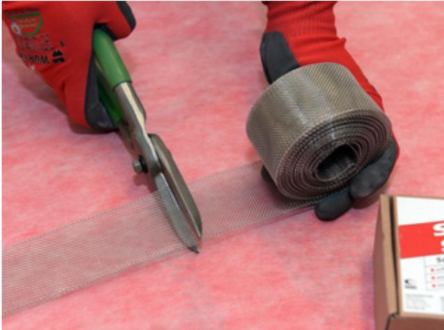
1) Das Sopro SchnittSchutzBand auf die benötigte Länge zurechtschneiden. Es ist darauf zu achten, dass ca. 4 cm mehr abgelängt werden als nötig ...
