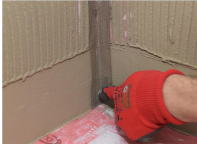
6) Wenn das Sopro SchnittSchutzBand über Eck eingebaut wird, das Band mittels Kelle oder der Hand in die gewünschte Position bringen und ebenfalls fest in den Fliesenkleber einbetten.
