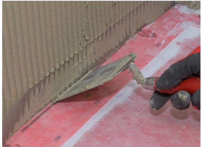
4) Anschließend das Band mit einer Kelle vollflächig in den Fliesenleber einbetten, ...
