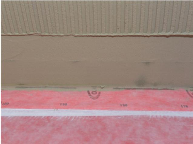
5) ... sodass das Band vollständig vom Fliesenkleber umschlossen ist.
