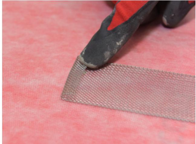
2) ... damit die Enden vor der Verlegung noch umgeklappt werden können. So wird verhindert, dass etwaige scharfe oder spitze Enden die Abdichtung (z. B. Sopro AEB 640) beschädigen.
