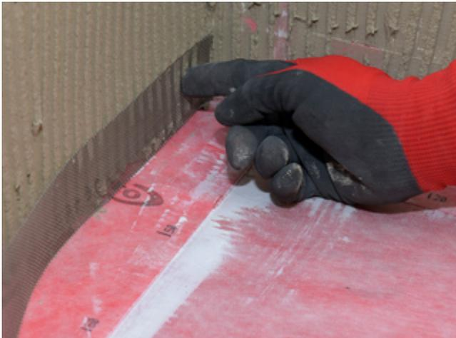
3) Das Sopro SchnittSchutzBand in das für die Fliesenverlegung aufgezahnte Kleberbett einlegen.
