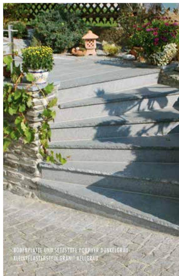
BODENPLATTE UND SETZSTUFE PORPHYR DUNKELGRAU
