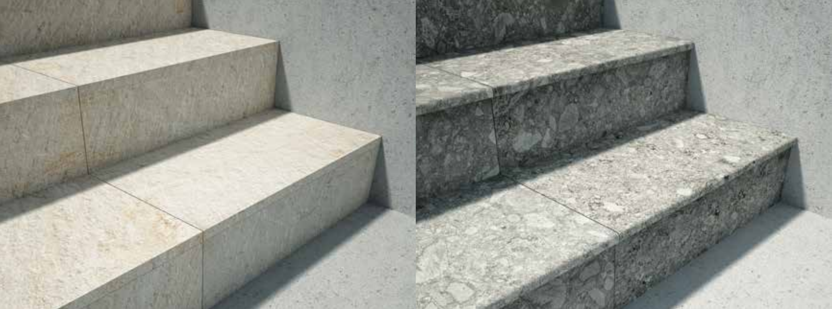
Installation mit abgerundeter Kante
